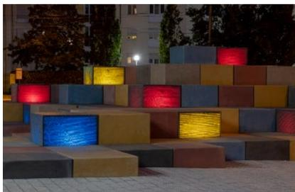
Vierundzwanzig Kuben des „Urban Star“ sind aus Lichtbeton hergestellt und mit farbigen LED-Innenleuchten ausgestattet. Bei Tageslicht prägen die mit Pigmenten von LANXESS durchgefärbten
