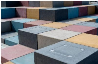
Bei den Lichtbetonkuben bildet eine horizontale Betonplatte aus geschliffenem anthrazitfarbenem Normalbeton einen revisionierbaren Abschluss nach oben. Foto: LANXESS AG
