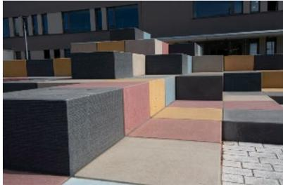
Die Betonkuben des „Urban Star“ besitzen auf der Oberfläche ein pyramidenförmiges flaches Dachgefälle. So bleibt kein Wasser auf der Oberfläche und die Gefahr einer Vereisung im Winter ist gering. Die Pflasterung des Platzes mit hellgrauen Betonwerksteinen ergibt zusammen mit den Betonkuben ein einheitliches Fugenbild. Foto: LANXESS AG
